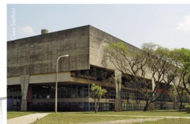
FAU - Faculdade de Arquitetura e Urbanismo da Universidade de São Paulo, SP Obteve o 1º Prêmio da Bienal Internacional de Arquitetura de São Paulo. Estrutura em concreto protendido, executada com o Sistema Ferraz de Protensão. Arquitetura de João B. Vilanova Artigas.
