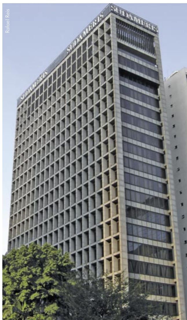
Sede Banco Sudameris, SP Gerenciamento dos projetos e obras. Arquitetura: Croce, Aflalo e Gasperini.
