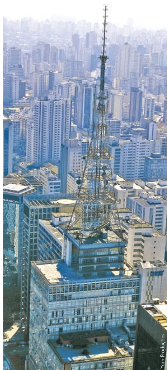
Torre TV Globo e Edifício Gazeta, SP Base e torre de transmissão de rádio e televisão.
