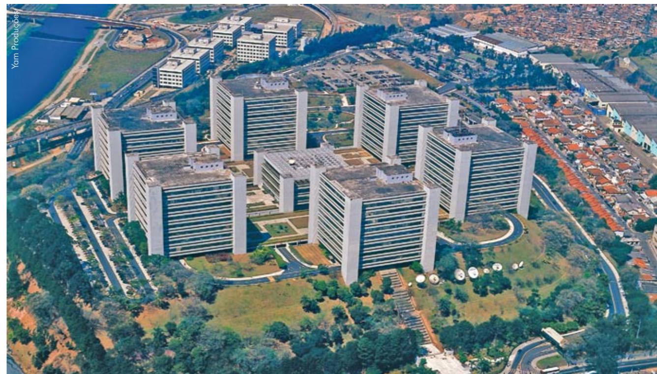
Centro Empresarial de São Paulo, SP Projeto estrutural.
