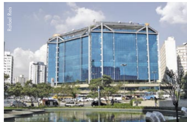
Centro Empresarial do Aço, SP Estrutura em aço utilizando 5.000 ton. Área construída 70.000 m 2 . Procedimentos especiais nos nós, soldas e montagem. Rigorosos controles de materiais. Arquitetura de Botti Rubim Arquitetos.
