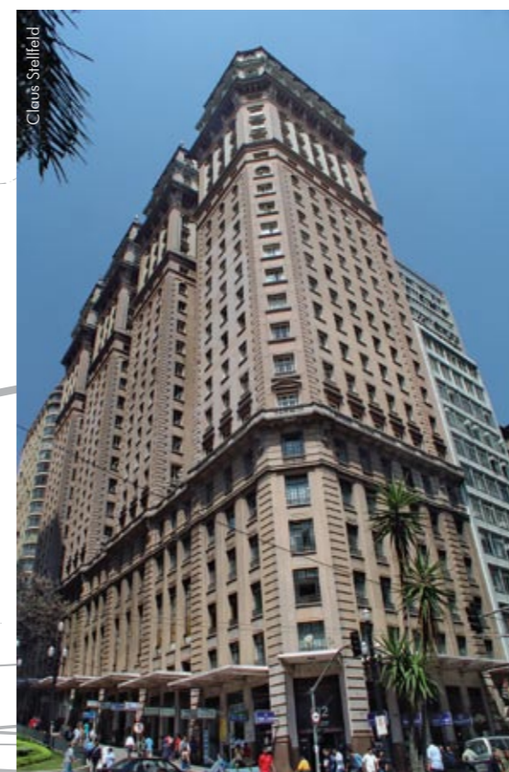
Edifício Martinelli, SP Projeto de restauro, reciclagem e modernização.
