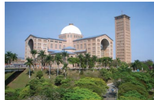
Basílica Nossa Senhora Aparecida, SP Projeto estrutural, das fundações e da cobertura em cúpula.
