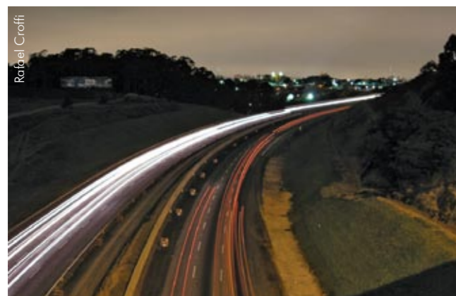
Rodovia dos Bandeirantes, SP
