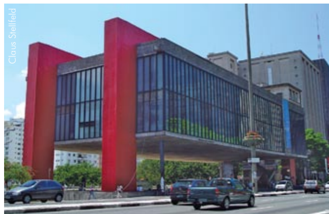
MASP - Museu de Arte de São Paulo, SP 1961 a 1963 - Estrutura protendida pelo Processo Ferraz, 74 metros de vão livre, laje suspensa com 2.100m 2 de área. Marco da engenharia brasileira, recorde à época da construção. Arquitetura de Lina Bo Bardi.
