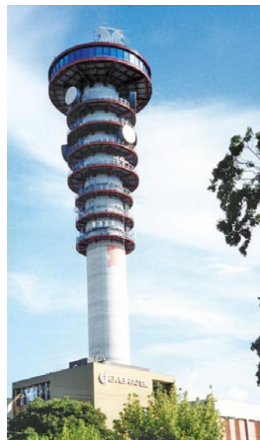
Torre de Telecomunicações Embratel, PR
