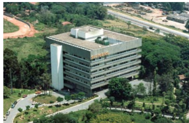
Edifício Siemens, SP O prédio, com projeção de apenas 2.227 m 2 , está implantado em terreno de 113.850 m 2 , topografia bastante acidentada e densa vegetação. O projeto, em concreto aparente, atendeu às diretrizes da Siemens, Alemanha, onde predominam escritórios panorâmicos, circundados por passarelas. Projeto e Supervisão técnica da construção pela Figueiredo Ferraz.
