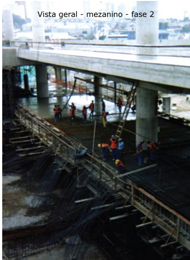
Concretagem da laje da fase 2 - mezanino
