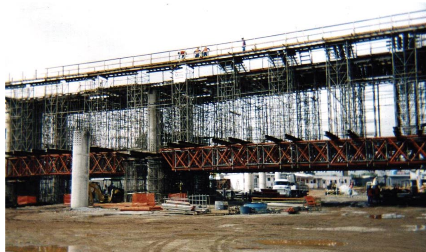
Montagem do cimbramento especial
