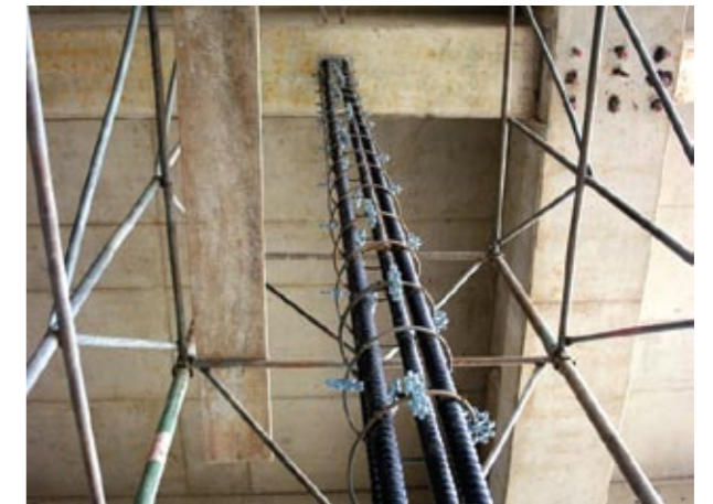
Detalhe de tirante entre os pisos VLP e Mezanino
