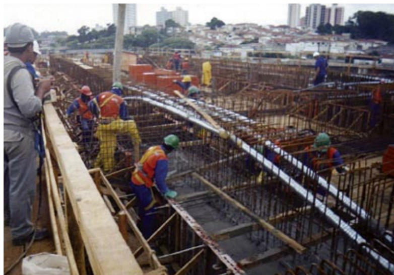
Concretagem do piso VLP, observando-se as bainhas dos cabos de protensão
