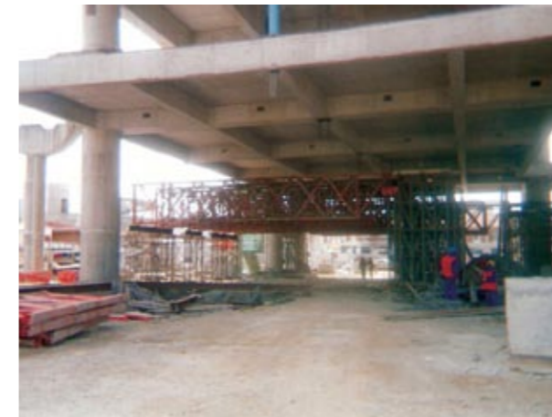
Vista da estrutura do piso mezanino
