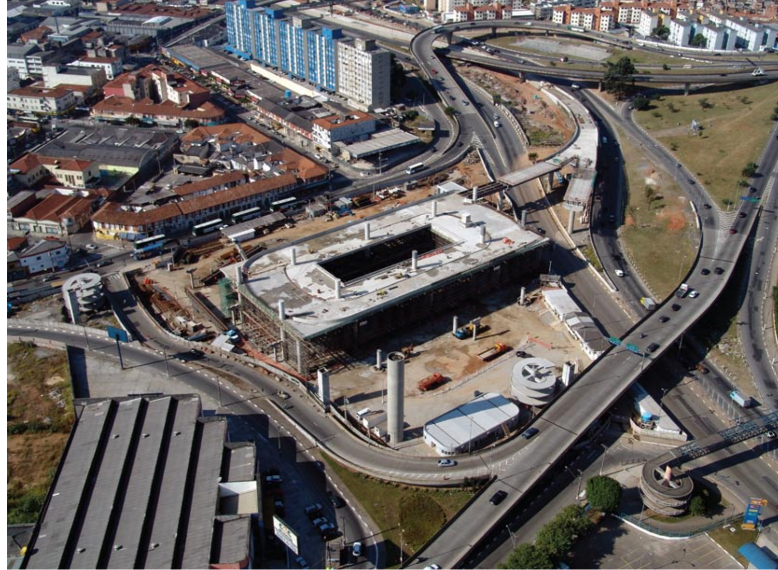
Laje do piso VLP concluída
