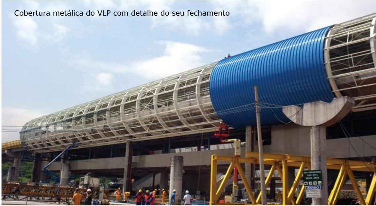
Vista geral - mezanino - fase 2
