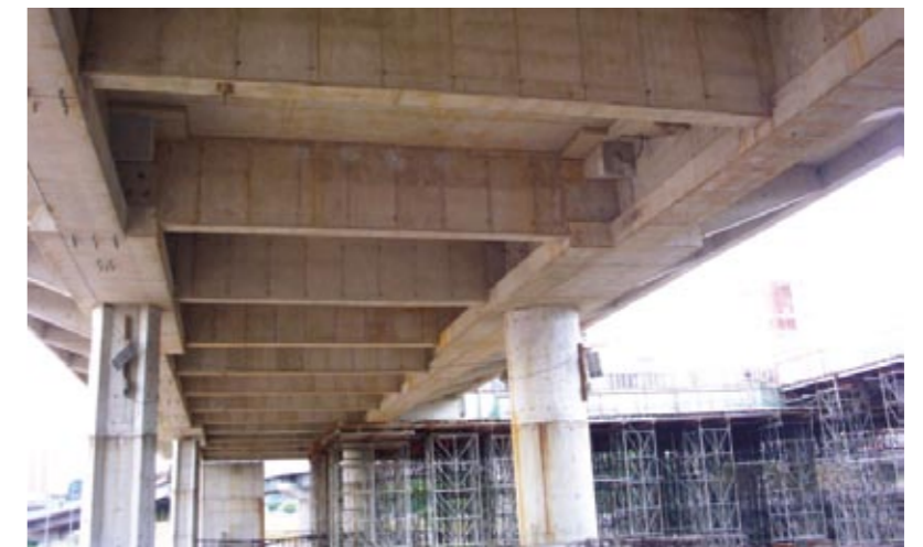
Vista da estrutura do nível VLP e detalhe dos nichos de protensão
