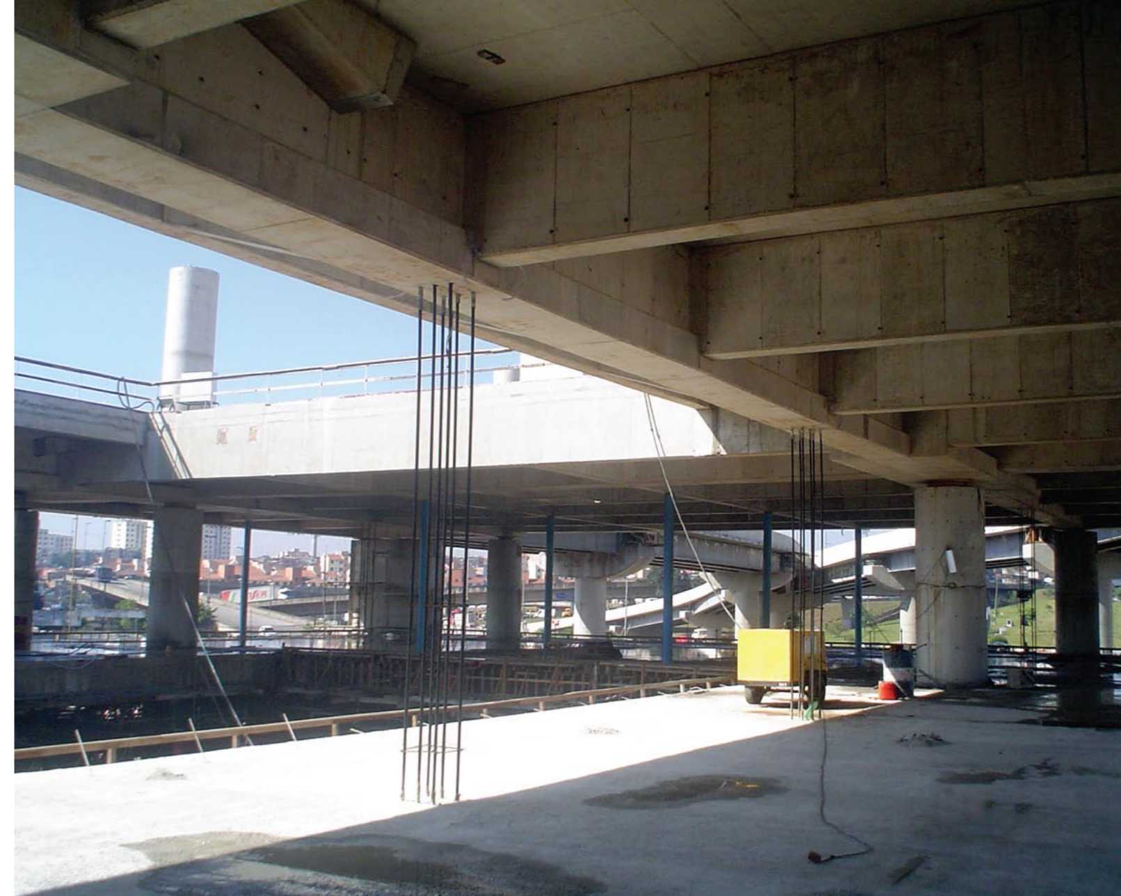
Viga do VLP com tirante do mezanino
