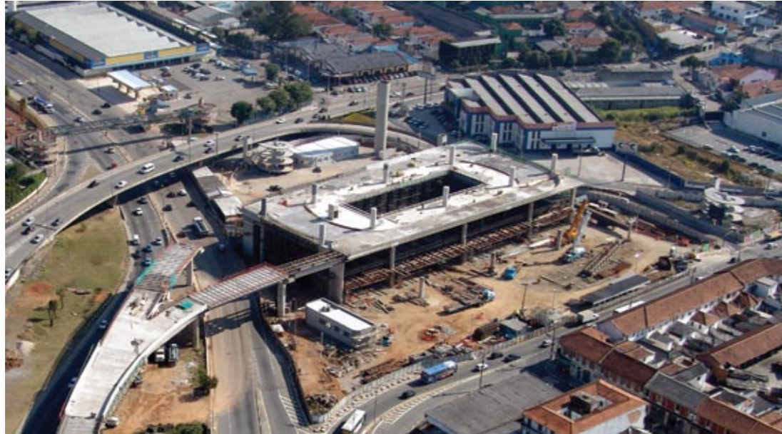
Execução do piso Mezanino
