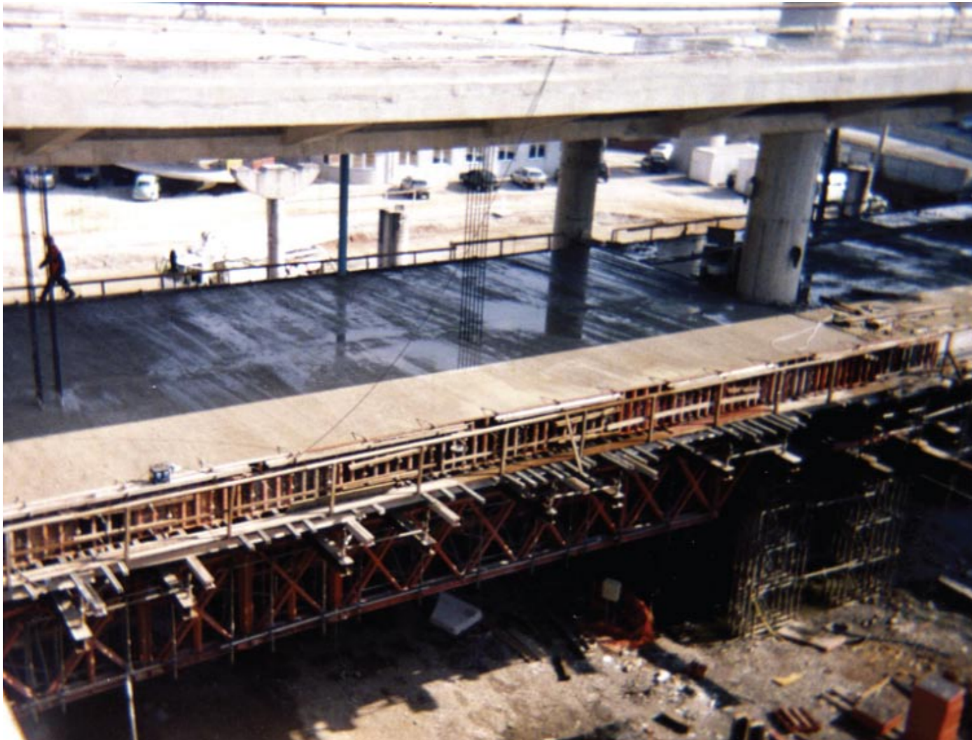
Laje do piso mezanino cimbrada sobre treliça com 25m de vão
