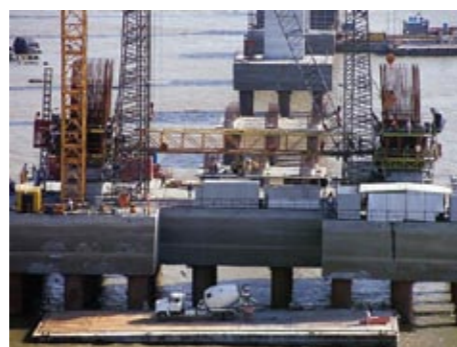
Bloco de fundação de uma torre
