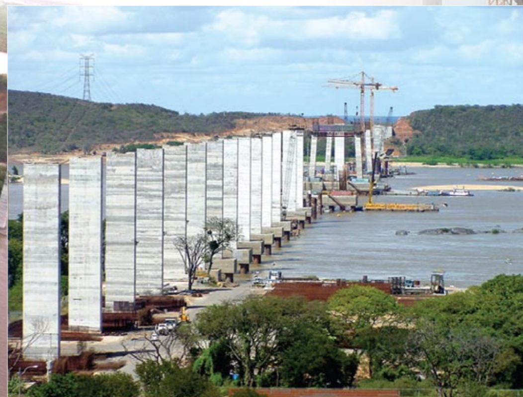
Vista geral dos pilares do acesso sul
