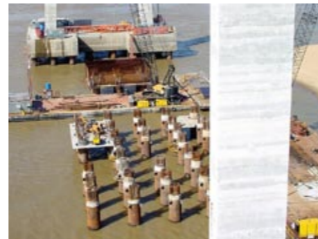
Vista das estacas do P28
