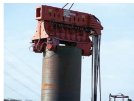
Equipamento de cravação das camisas metálicas
