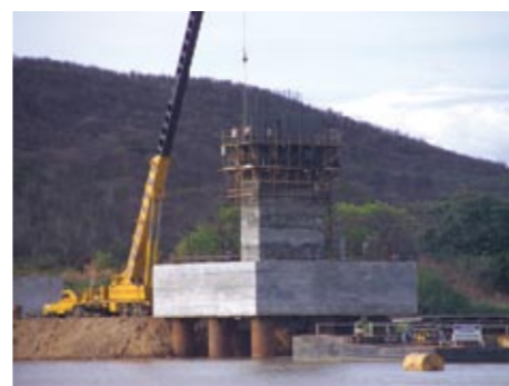
Bloco concretado
