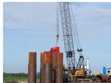
Cravação das camisas metálicas
