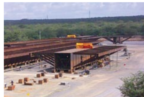
Montagem de módulo para lançamento
