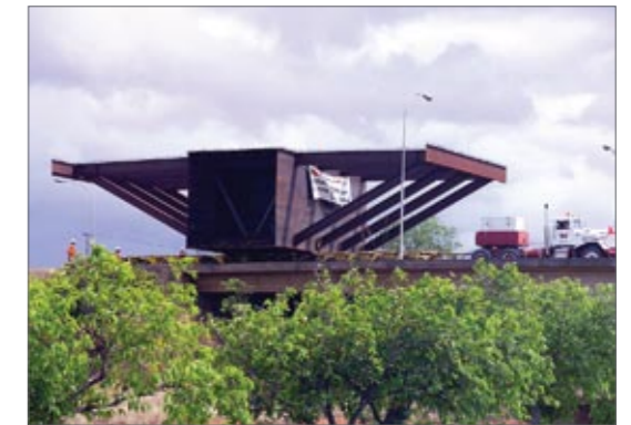
7. Transporte de aduela em direção à obra
