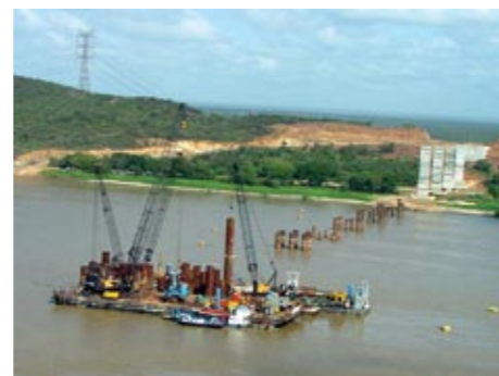
Vista aérea das fundações do lado norte
