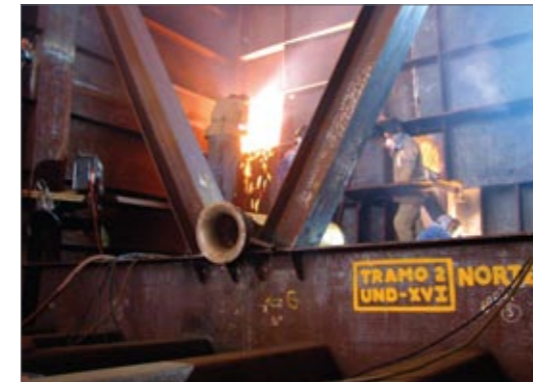
5. Montagem da aduela metálica
