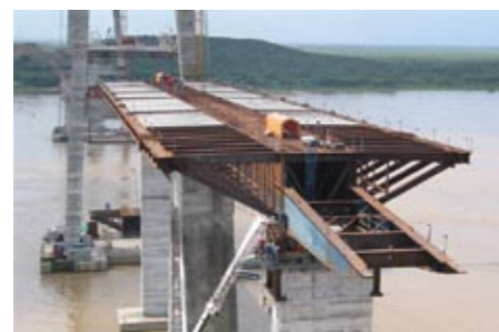
Vista do tabuleiro entre a P26 e P30
