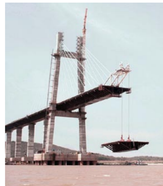
Içamento de aduela no vão central
