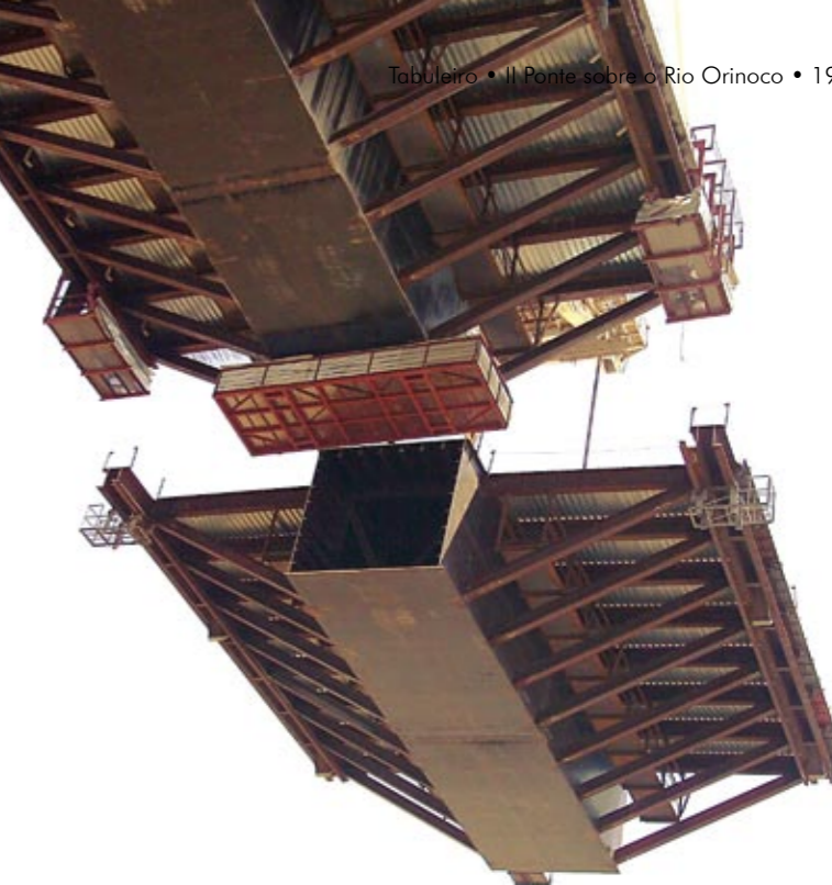
Detalhe do içamento de aduela de 24 metros
