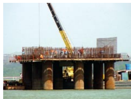
Bloco com as pré-lajes já executadas
