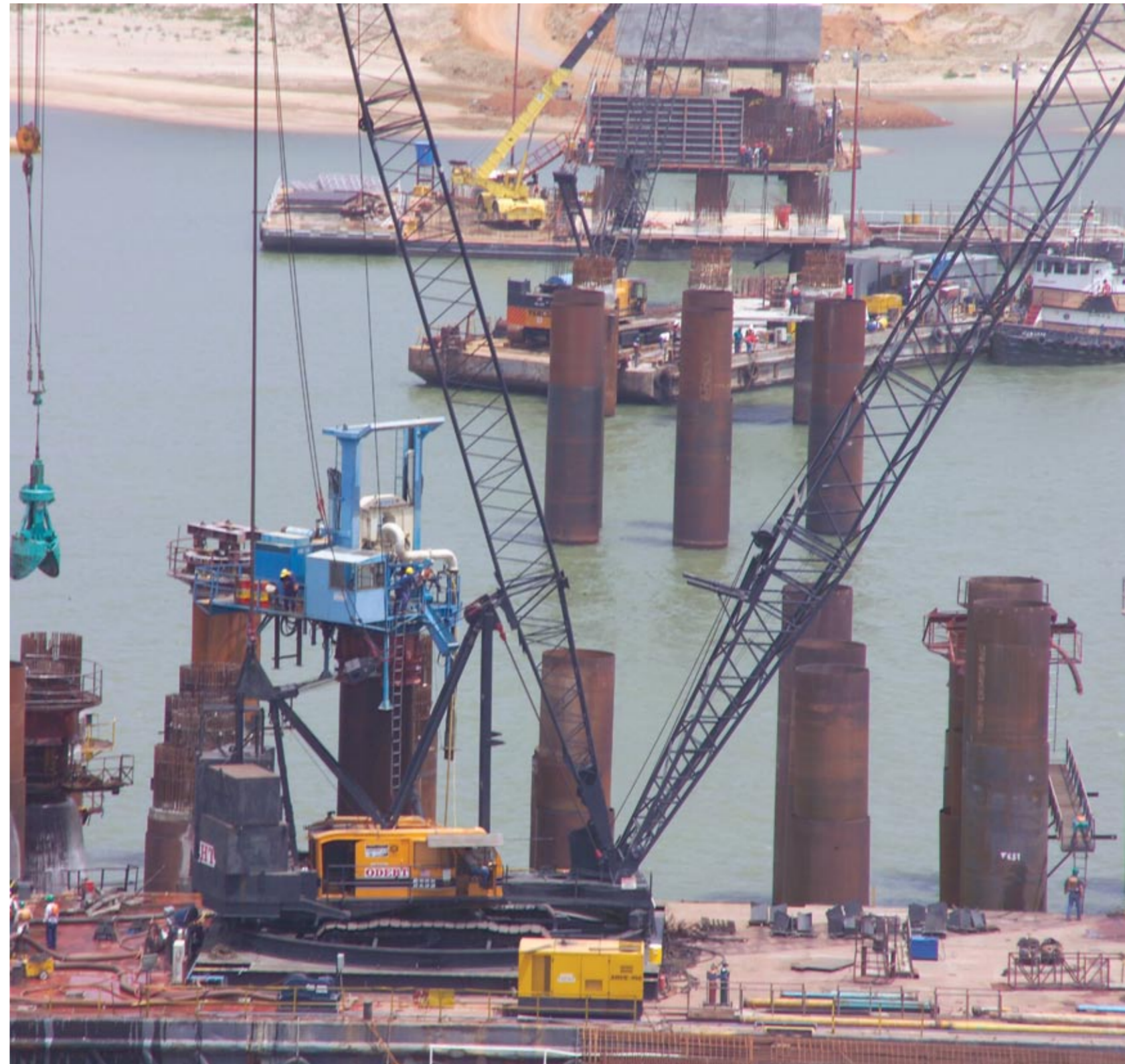
Vista aérea das fundações do lado sul
