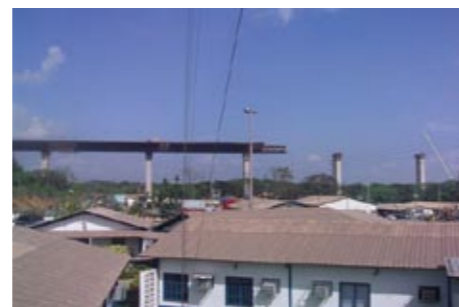
Vista de módulo em movimentação
