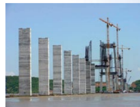
Pilares já executados e torres em execução
