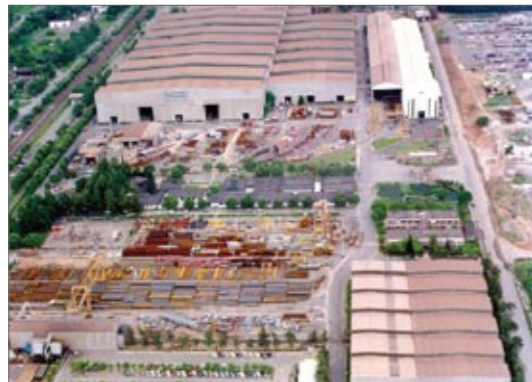
1. Fabricação da estrutura metálica no Brasil
