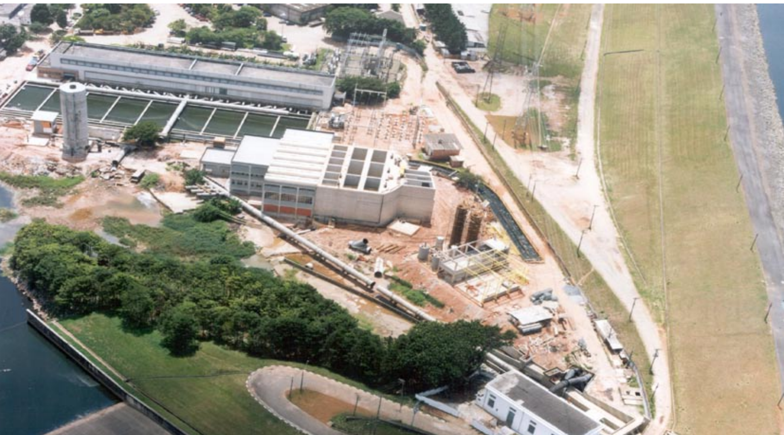
Nova estação elevatória Guarapiranga e os decantadores que foram desativados
