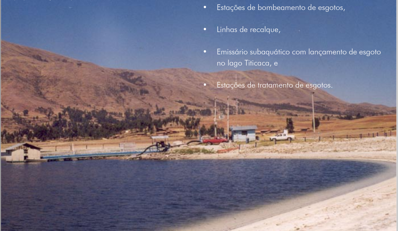
Captação no Lago Piuray - Cusco
