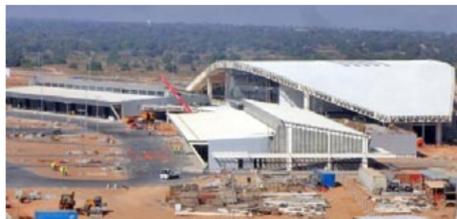
Terminal de passageiros
