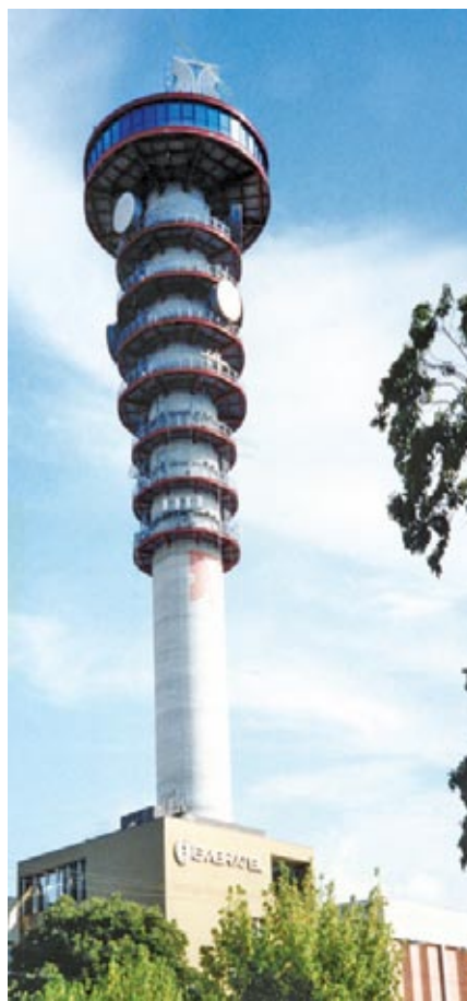
Torre de Telecomunicações Embratel, PR
