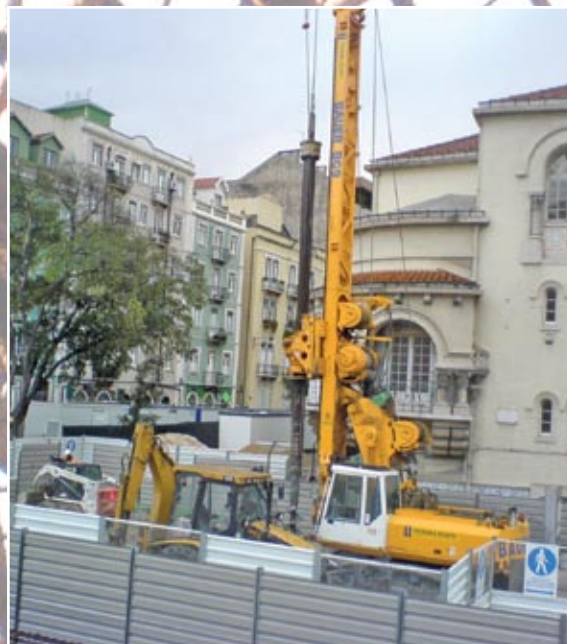
Perfuração de estacas
