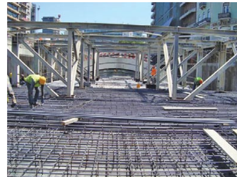
Armadura da laje de piso do Átrio Norte
