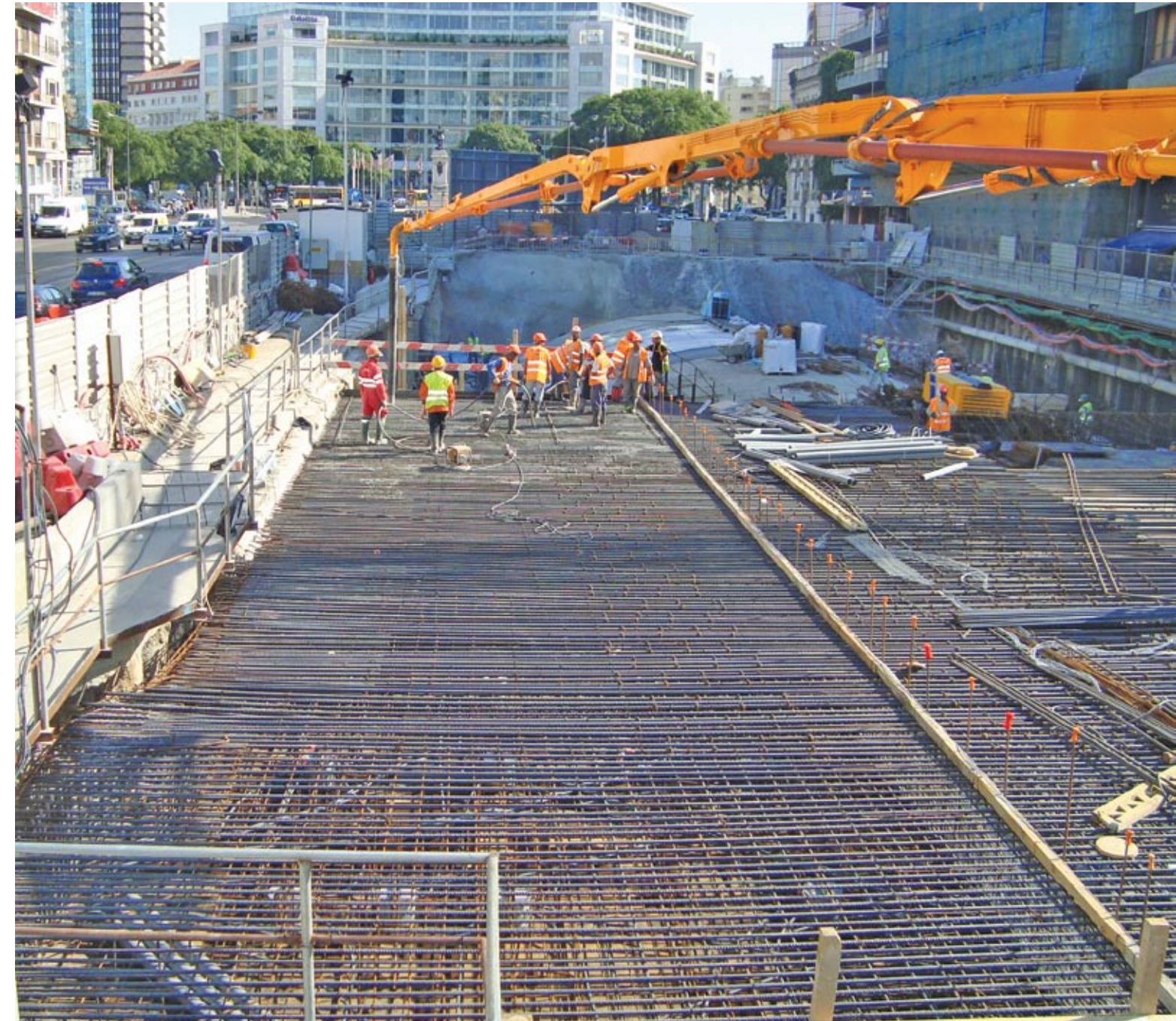
Montagem da armadura da laje de cobertura
