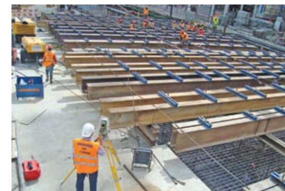
Monitoramento topográfico do cimbramento da cobertura
