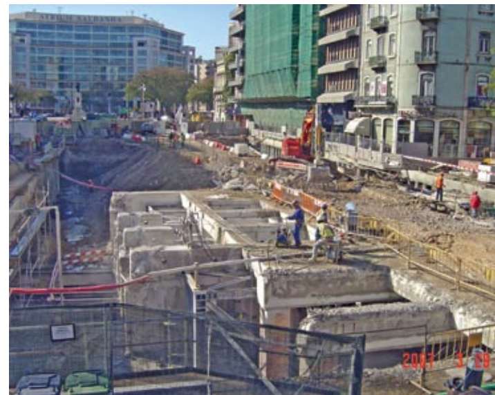
Detalhe de demolição - vigas paredes
