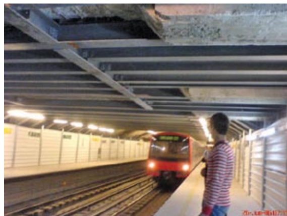
Proteção de via sob o átrio
