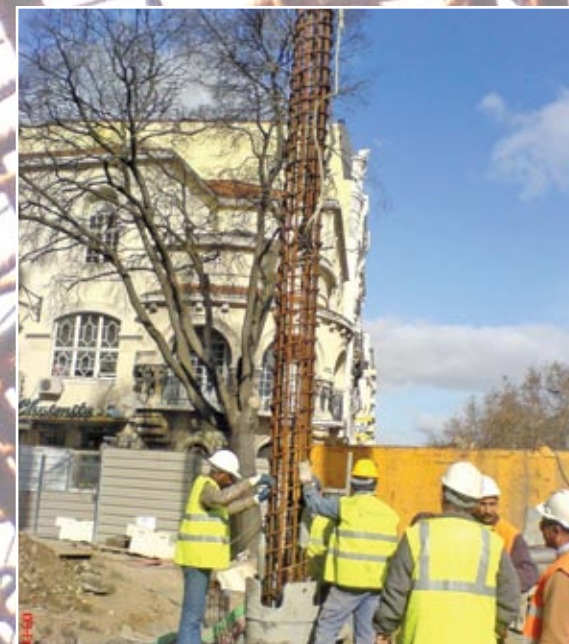
Posicionamento de armadura das estacas
