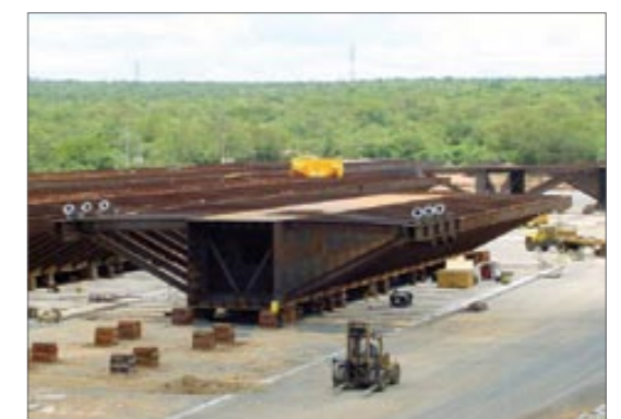
8. Vista do pátio de montagem do tabuleiro para posterior movimentação
