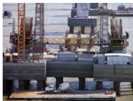
Bloco de fundação de uma torre
