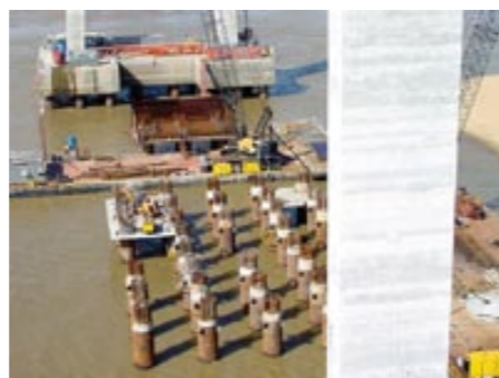
Vista das estacas do P28
