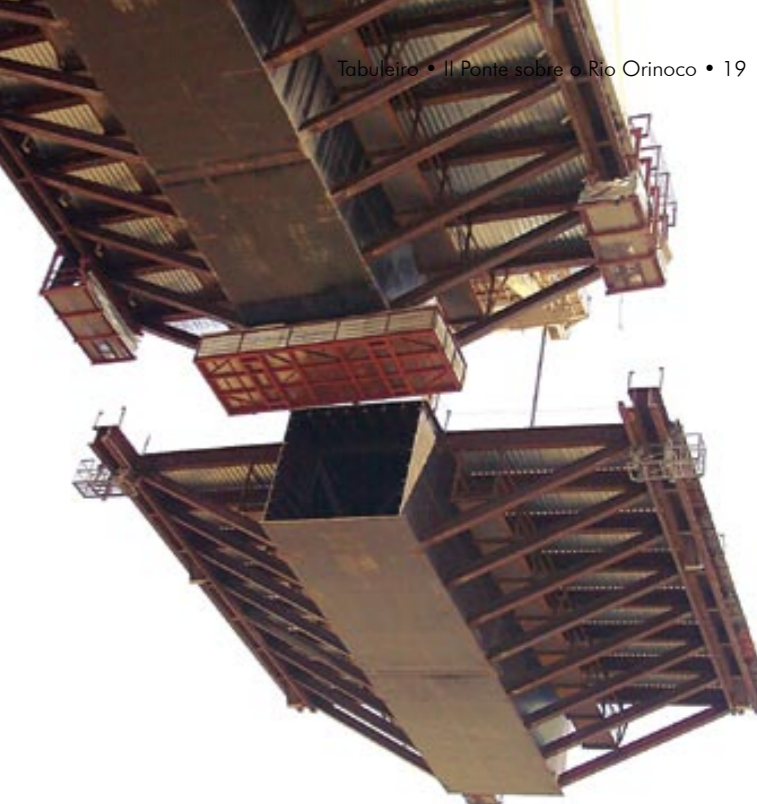
Detalhe do içamento de aduela de 24 metros
