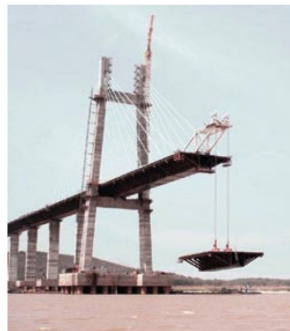
Içamento de aduela no vão central
