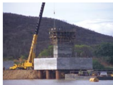
Bloco concretado
