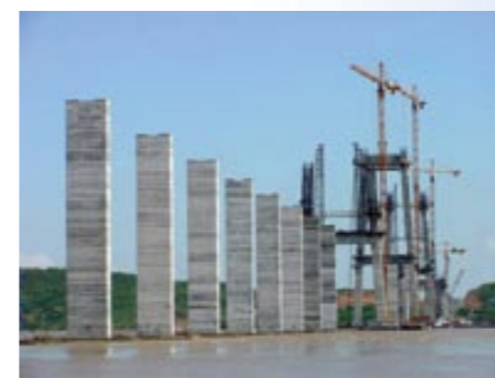
Pilares já executados e torres em execução
