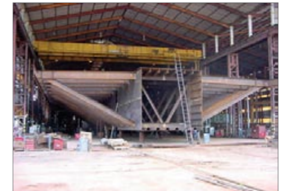
6. Saída de aduela da oficina
