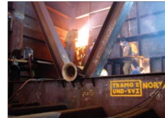
5. Montagem da aduela metálica
