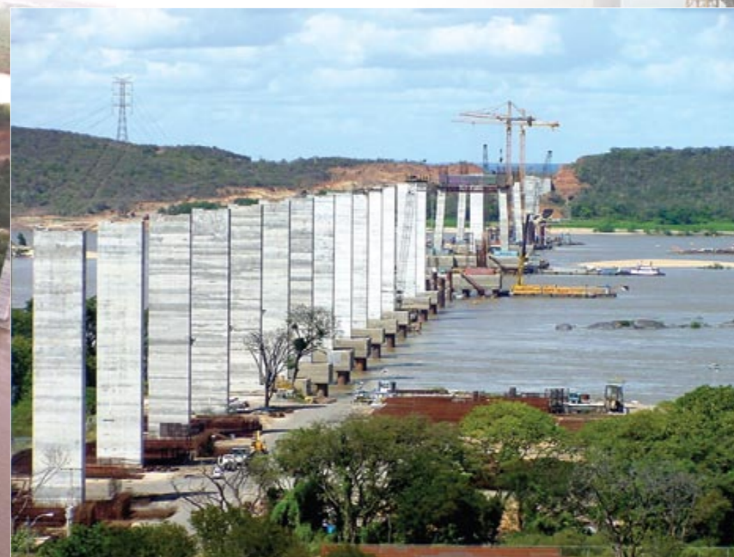
Vista geral dos pilares do acesso sul
