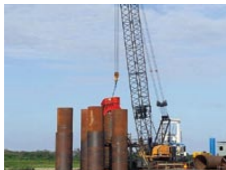
Cravação das camisas metálicas
