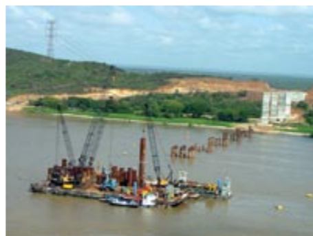
Vista aérea das fundações do lado norte
