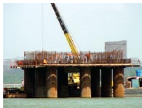
Bloco com as pré-lajes já executadas
