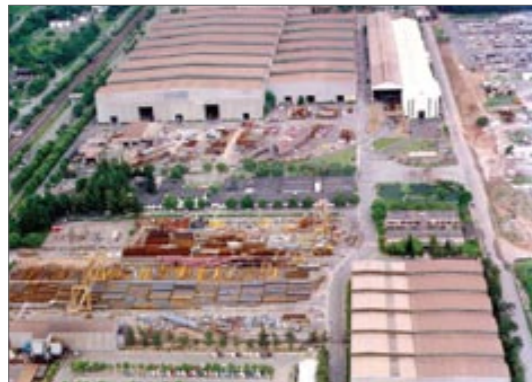
1. Fabricação da estrutura metálica no Brasil
