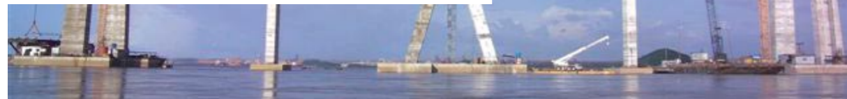
Movimentação do tabuleiro no trecho central entre P26 e P30
