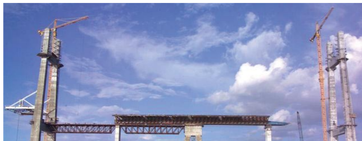
Movimentação do tabuleiro no trecho central entre P26 e P30
