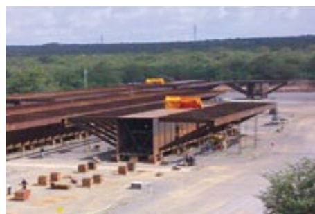
Montagem de módulo para lançamento
